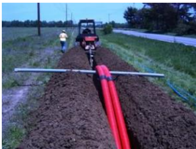
Рис. Ошибка! Текст указанного стиля в документе отсутствует..12 – Приклад прокладання підземних кабельних ЛЕП
