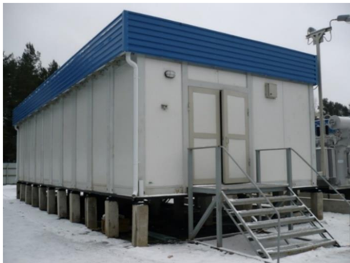
Рис. Ошибка! Текст указанного стиля в документе отсутствует..31 – РУ 35 кВ закритого типу
