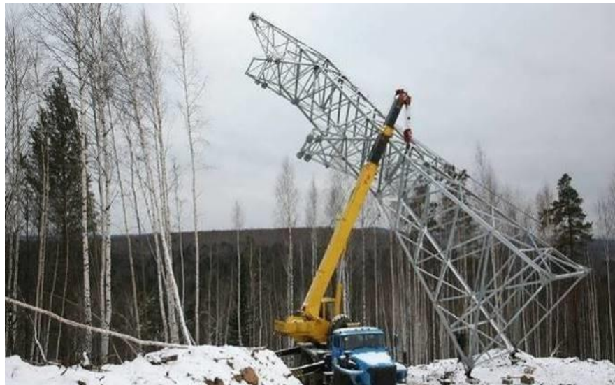
Рис. Ошибка! Текст указанного стиля в документе отсутствует..155 – Приклад монтажу опори ПЛ
