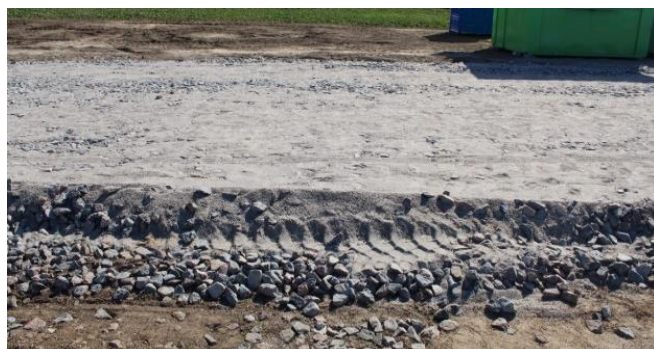
Рис. Ошибка! Текст указанного стиля в документе отсутствует..13 – Прокладання під'їзних доріг (технологічних проїздів) до майданчиків
