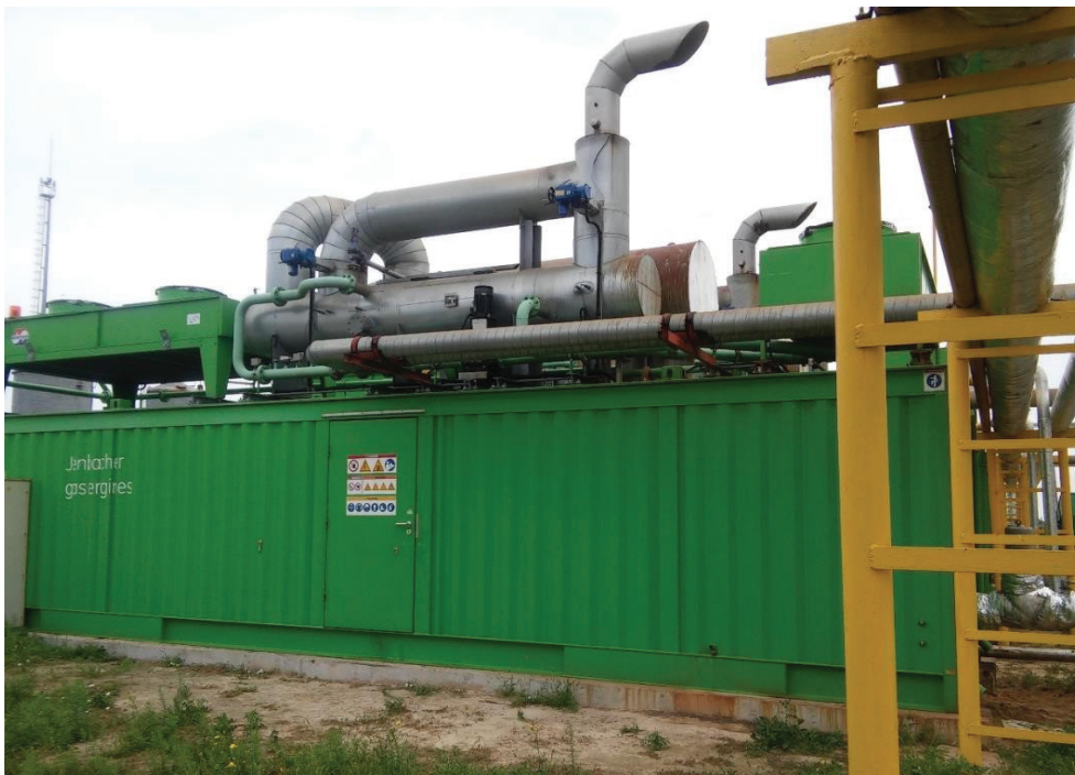
Рисунок 2 – Когенераційна установка з газопоршневим двигуном, що працює на біогазу
