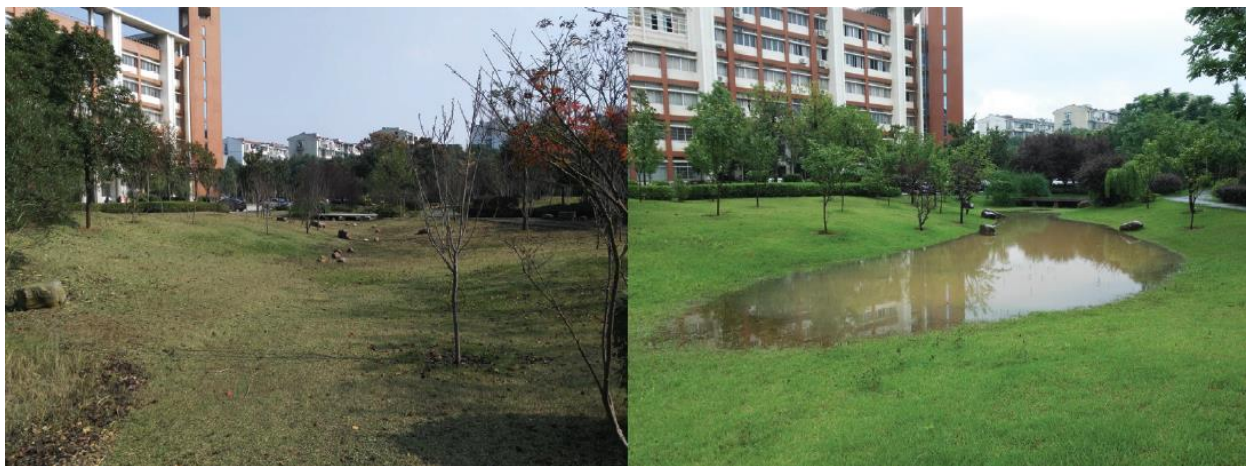
Рис. 4.14 Сухий та заповнений ставок (до дощу – зліва, після дощу – справа)
