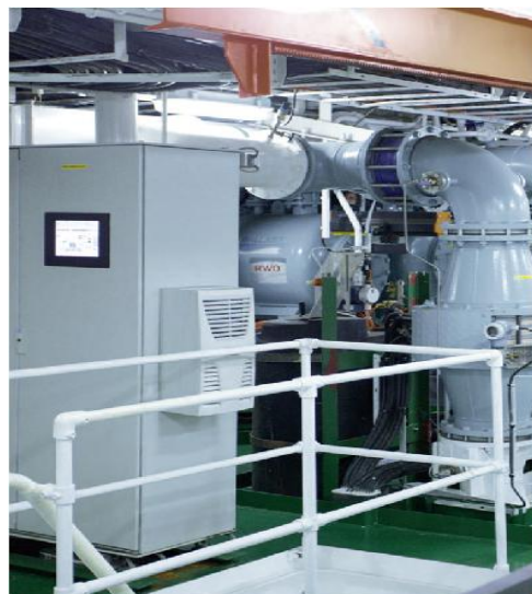
Рис. 2.13. Розташування системи CleanBallast RWO на судні
