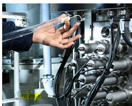
Рис. 3.10. Ультрафіолетові лампи з кварцевими колбами у складі УФ-реактора
