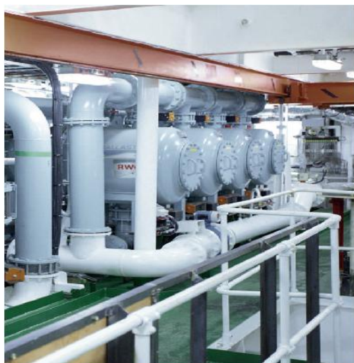
Рис. 2.13. Розташування системи CleanBallast RWO на судні
