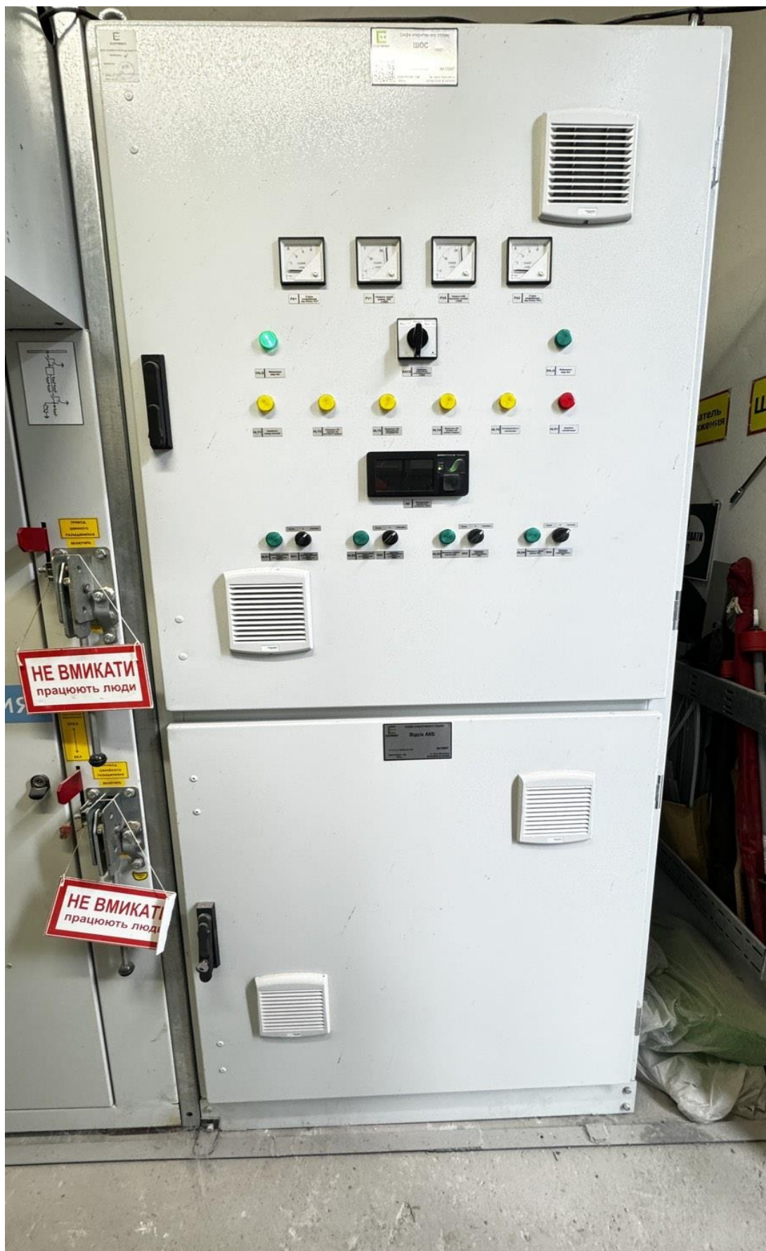
Рис. 4.12 – Шафа оперативного струму
