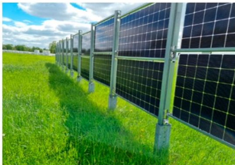
Рис. 3.7. Вертикальна агровольтаїчна установка з двосторонніми модулями
