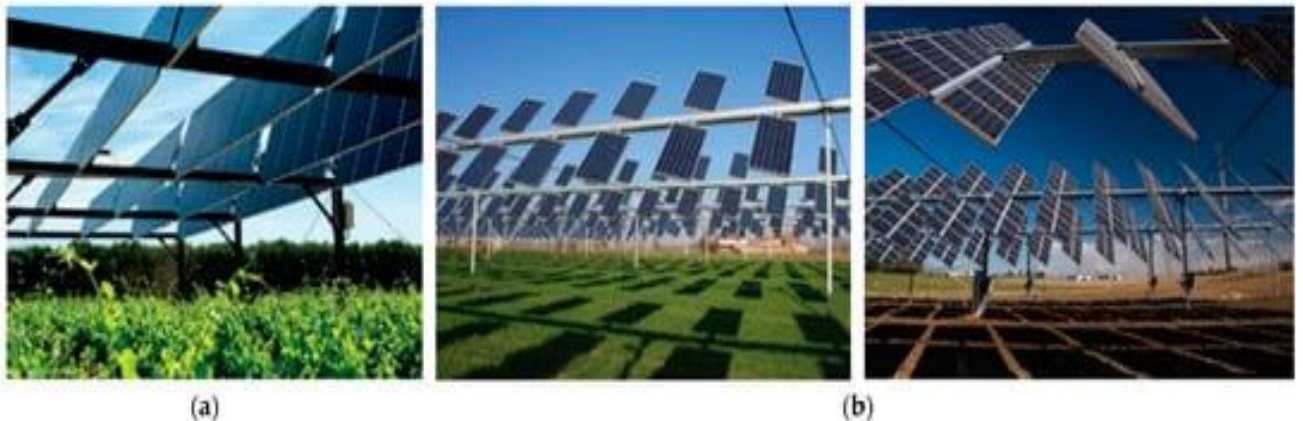
Рис. 3.6. (а) Одноосьовий модуль сонячного трекера та (б) двоосьовий модуль сонячного трекера.
