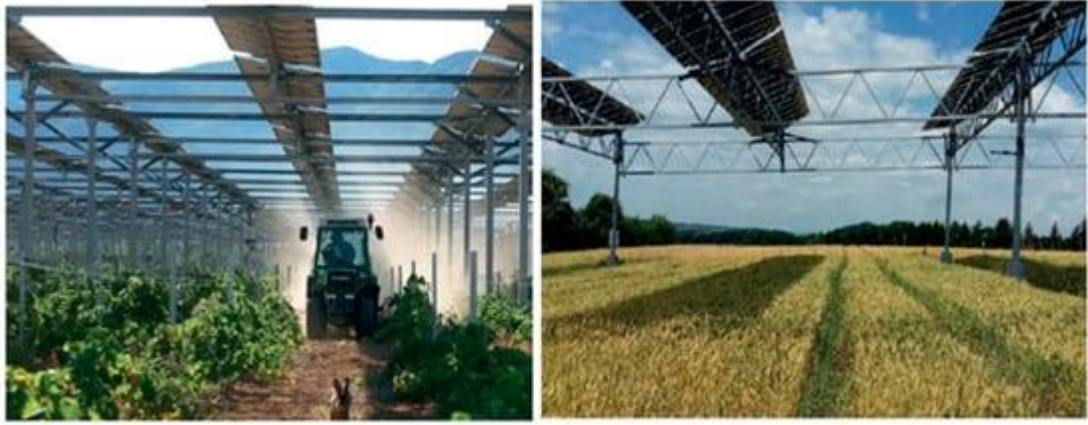
Рис. 3.5. Відстань між рядами панелей, що дозволяє рух сільськогосподарської техніки під фотоелектричними панелями © Fraunhofer ISE
