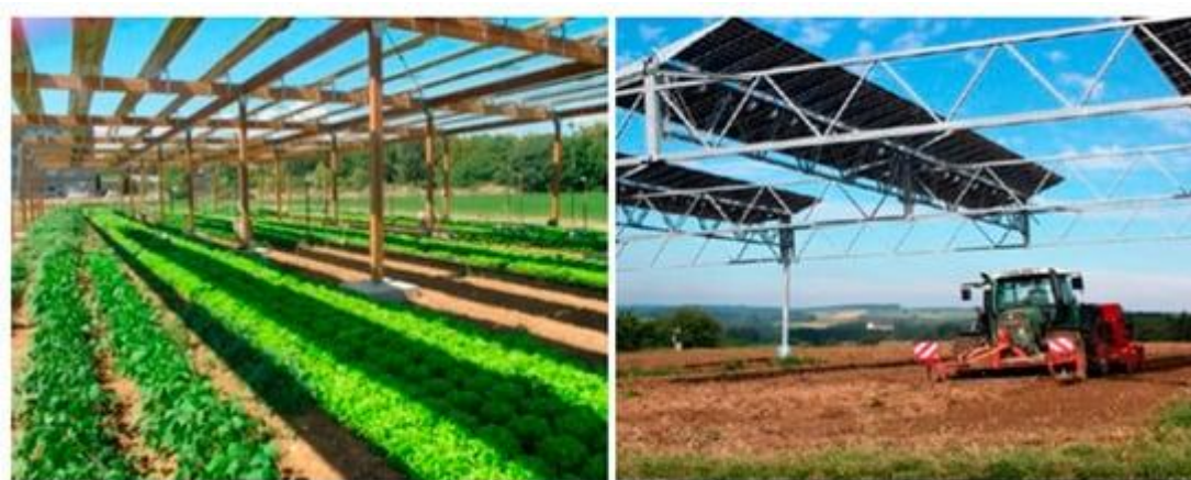
Рис. 3.3. (a) Панелі, встановлені на висоті 4 м у Монпельє © Dupraz, (b) Панелі, встановлені на висоті 5 м у Німеччині © Fraunhofer ISE
